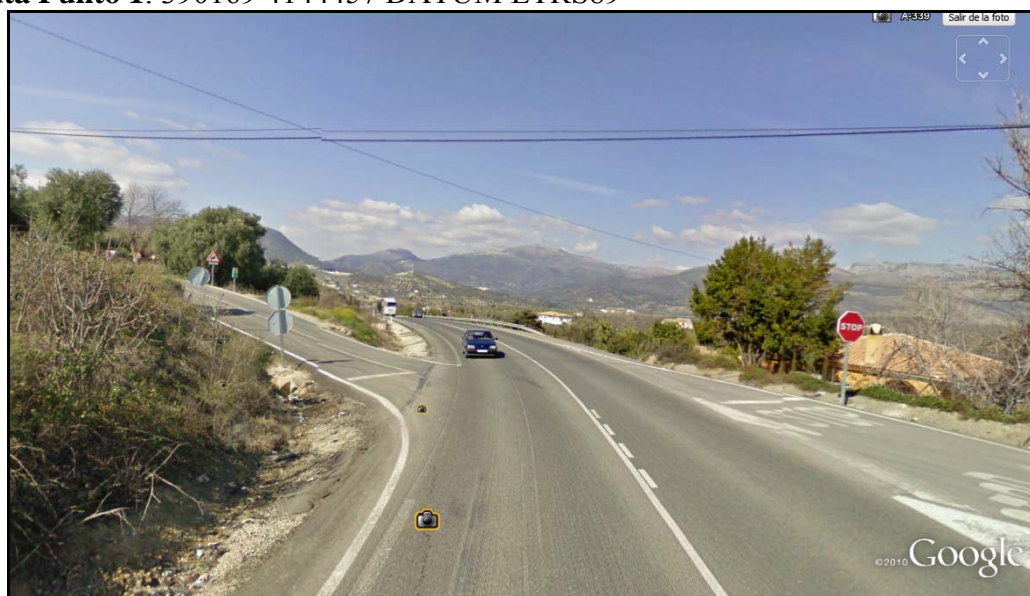
Fig. 3 Acceso zona sur. Punto 1
