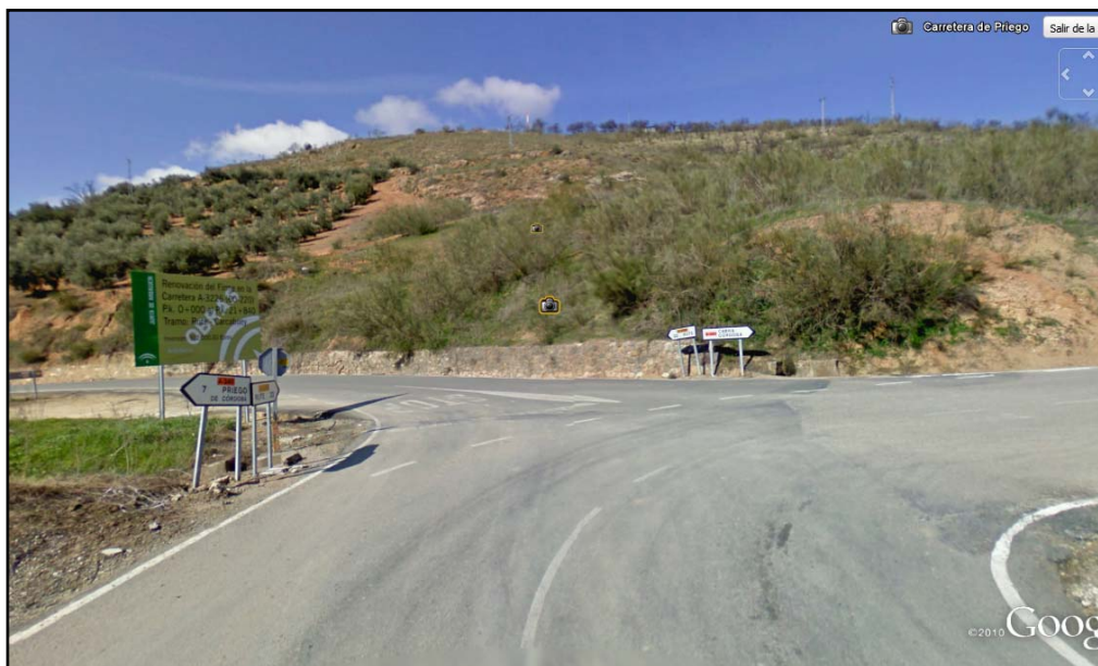
Fig. 4.- Acceso zona sur. Punto 2
