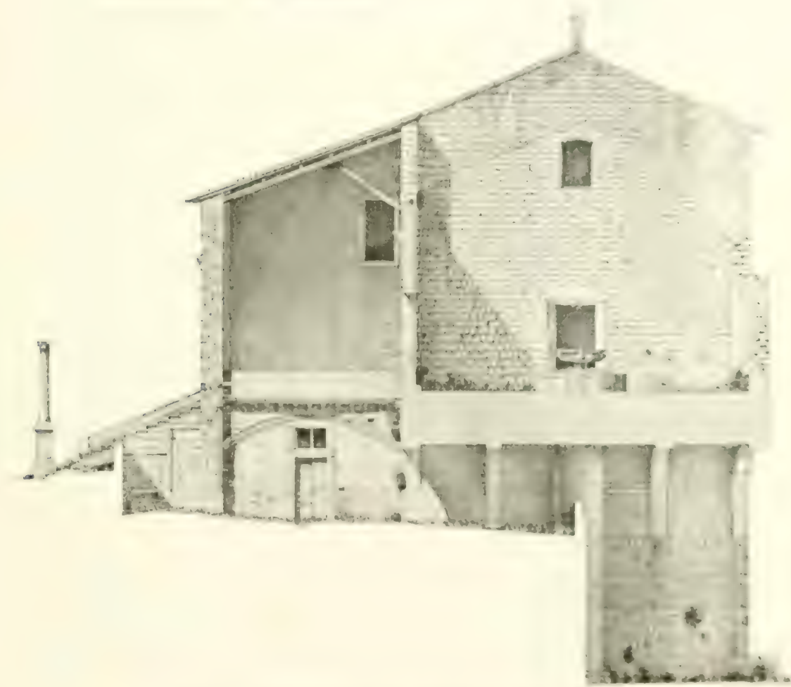
Fig. 10. — Veduta della facciata del conclave, dopo i lavori di restauro.
