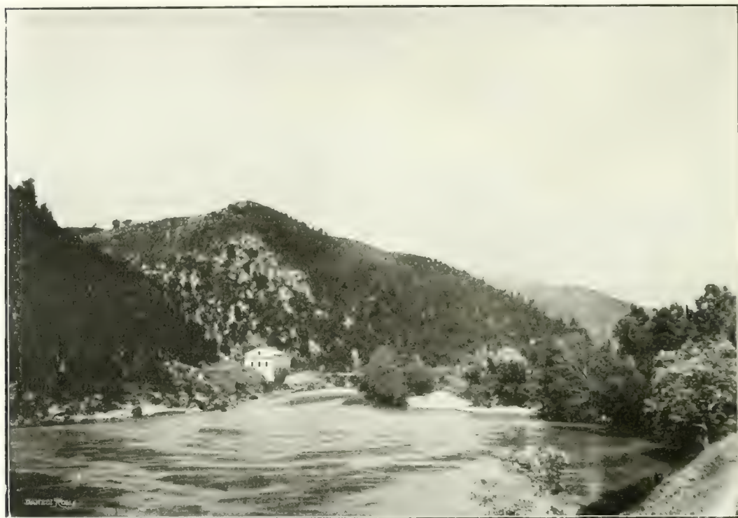
Fig. 3 — Lo stabilimento della Provincia a S. Egidio
