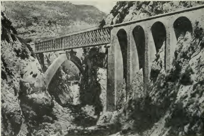
Coni. Viadukt över floden Bévéra på järnvägen Coni—Nizza.
