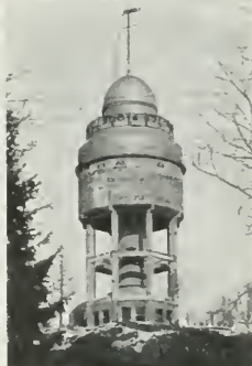
Naisvuoren vesi- ja näkötorni.
