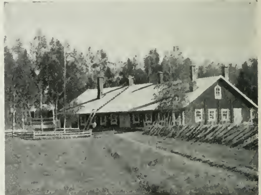
Navetta, puolikorkeat seinät, taitteinen välikatto.
